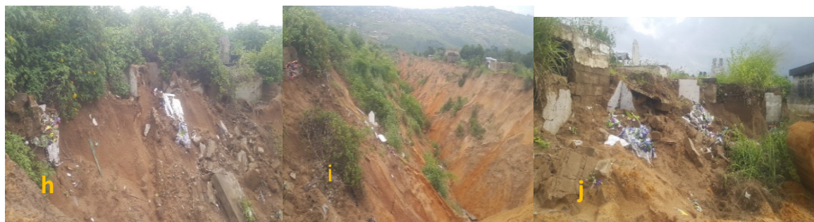
Figure 15h, 15i et 15j : Glissement de terrain emportant des parties de caveau)
