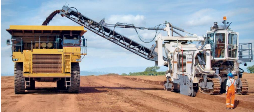
Figure N°13 – Chargement direct dans les camions-bennes
